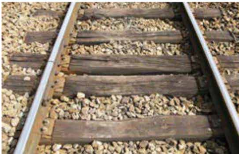
Rails courts sur traverses bois
