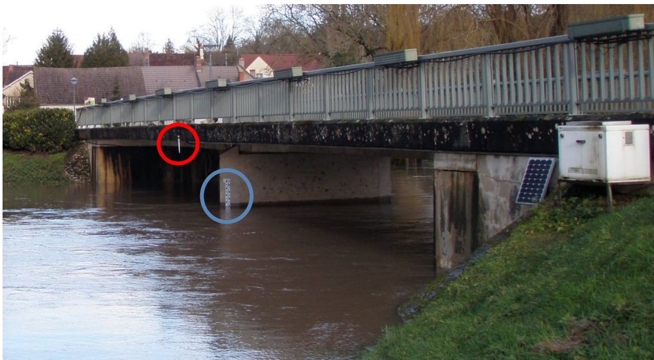
Figure 23: Station hydrométrique sur l'Indre à Montgivray (Indre) – on distingue l'échelle sur la pile centrale (en bleu), le radar juste au-dessus (en rouge), ainsi que le boîtier abritant les installations d'acquisition et son alimentation par panneau solaire
