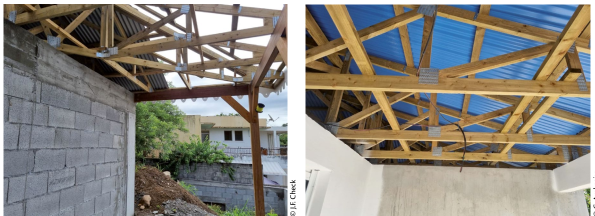
Figure 121 : Photos d'un auvent nécessitant un faux-plafond extérieur en sous-face
